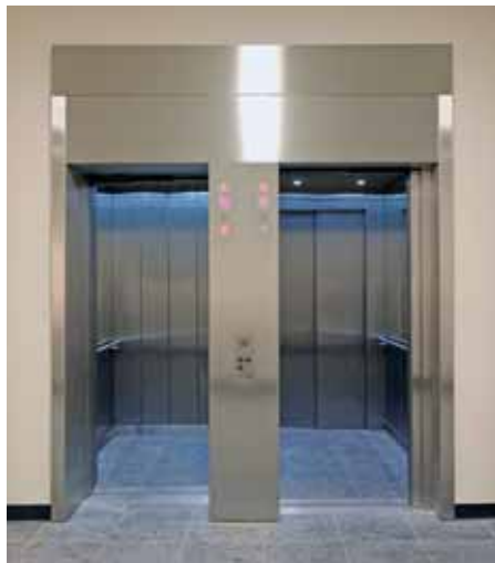
Shuttle-Aufzüge zu Tiefgarage und Kino
