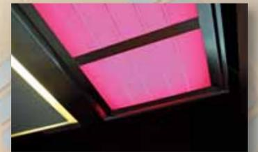
Kabinenbeleuchtung mit LEDs im Farbwechsel
